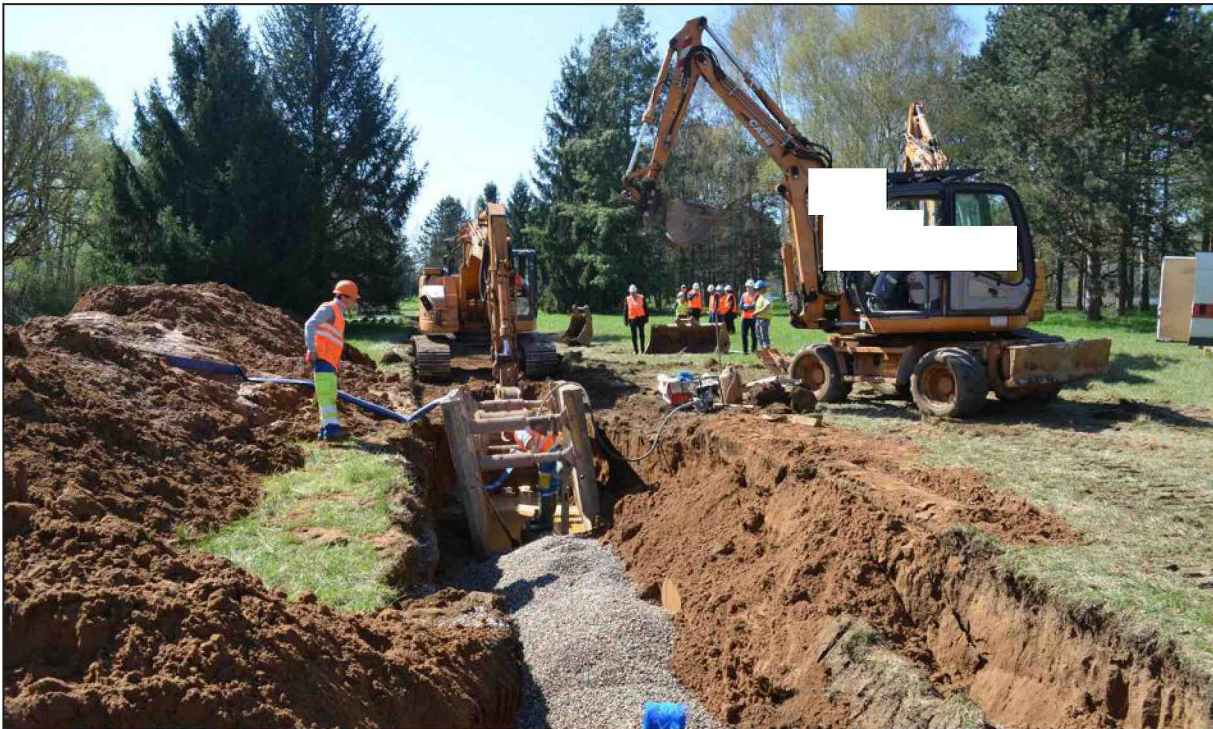
■ Un kilomètre de canalisation d'eau potable est remplacé aux Prés Saint-Jean. Photo Florent MULLER
